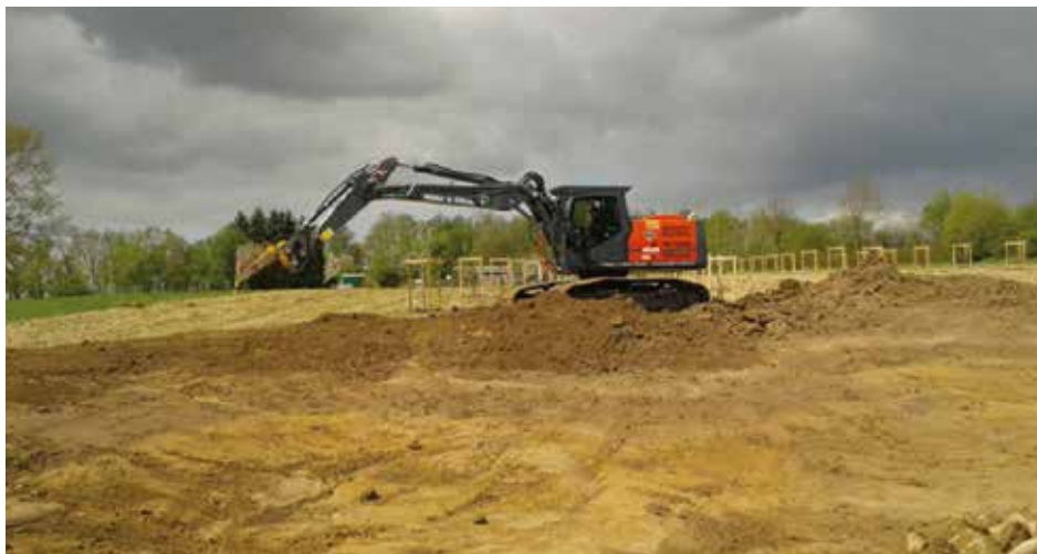
Mit viel Routine wird der Aushub durch den Baggerführer einplaniert.
