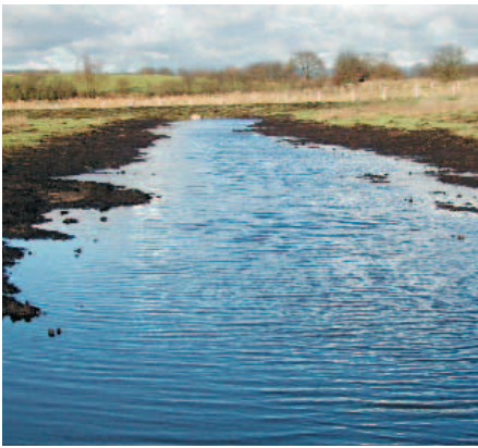
Schon kurze Zeit nach Abschluss der Erdbauarbeiten machten die Flutmulden ihrem Namen alle Ehre
